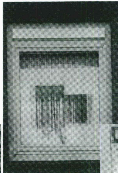
suskast aan de buitenzijde
